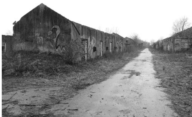
L'azoturerie-fulminaterie. Ces bâtiments dont la construction débuta en 1939 ne furent jamais achevés. Il ont été détruits (Photo Service régional de l'inventaire de Bretagne).
