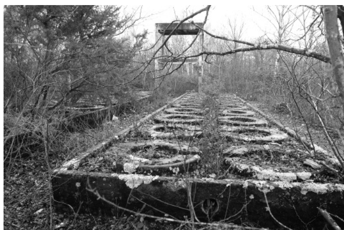
Des vestiges énigmatiques (fonderie) qui mériteraient une investigation approfondie avant leur destruction.
