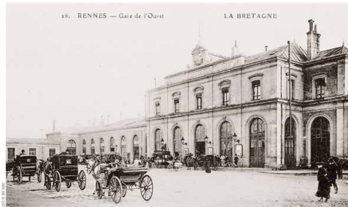
Gare de Rennes, au début du 20 e siècle. Dans la cour, des voitures attelées attendent les voyageurs.
