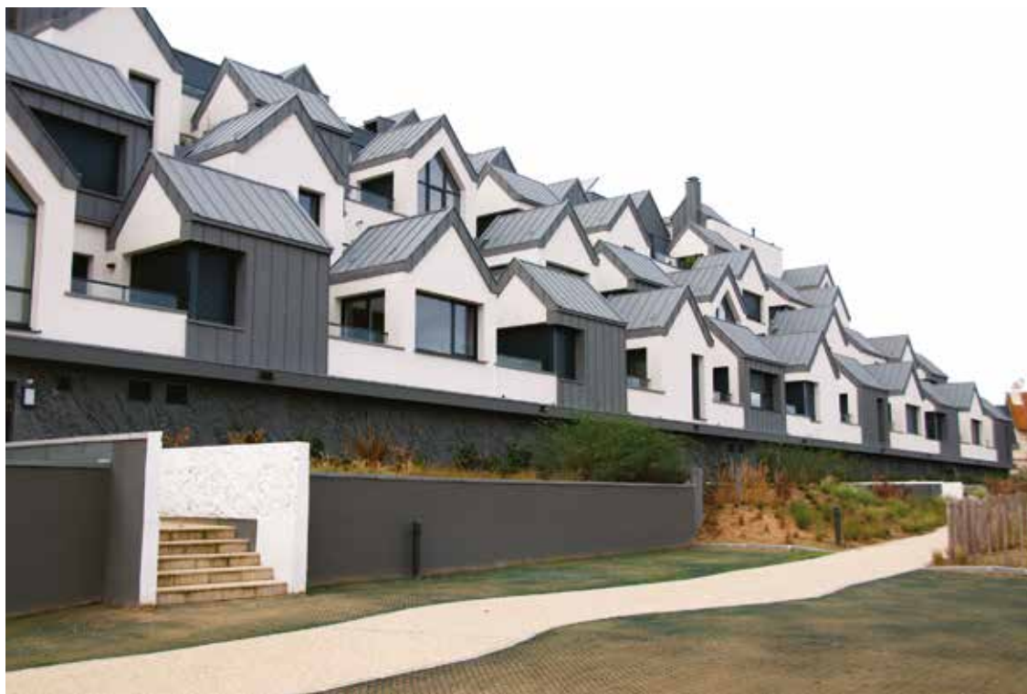
À l'arrière, la démultiplication des toitures comme autant de petites berniques.
