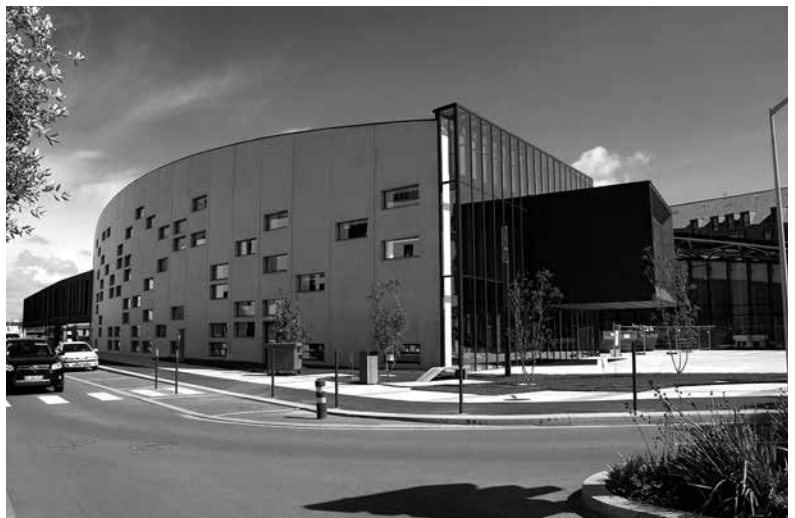
Côté intra-muros, du mur percé de pixels surgit la bande passante des bureaux qui traverse la médiathèque. Un écran numérique crée un événement cinématique.
