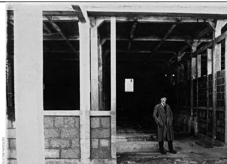
Ci-contre, en haut, Rodolphe Novello sur le chantier des Papeteries de Bretagne. En bas, un repas sur le chantier.
