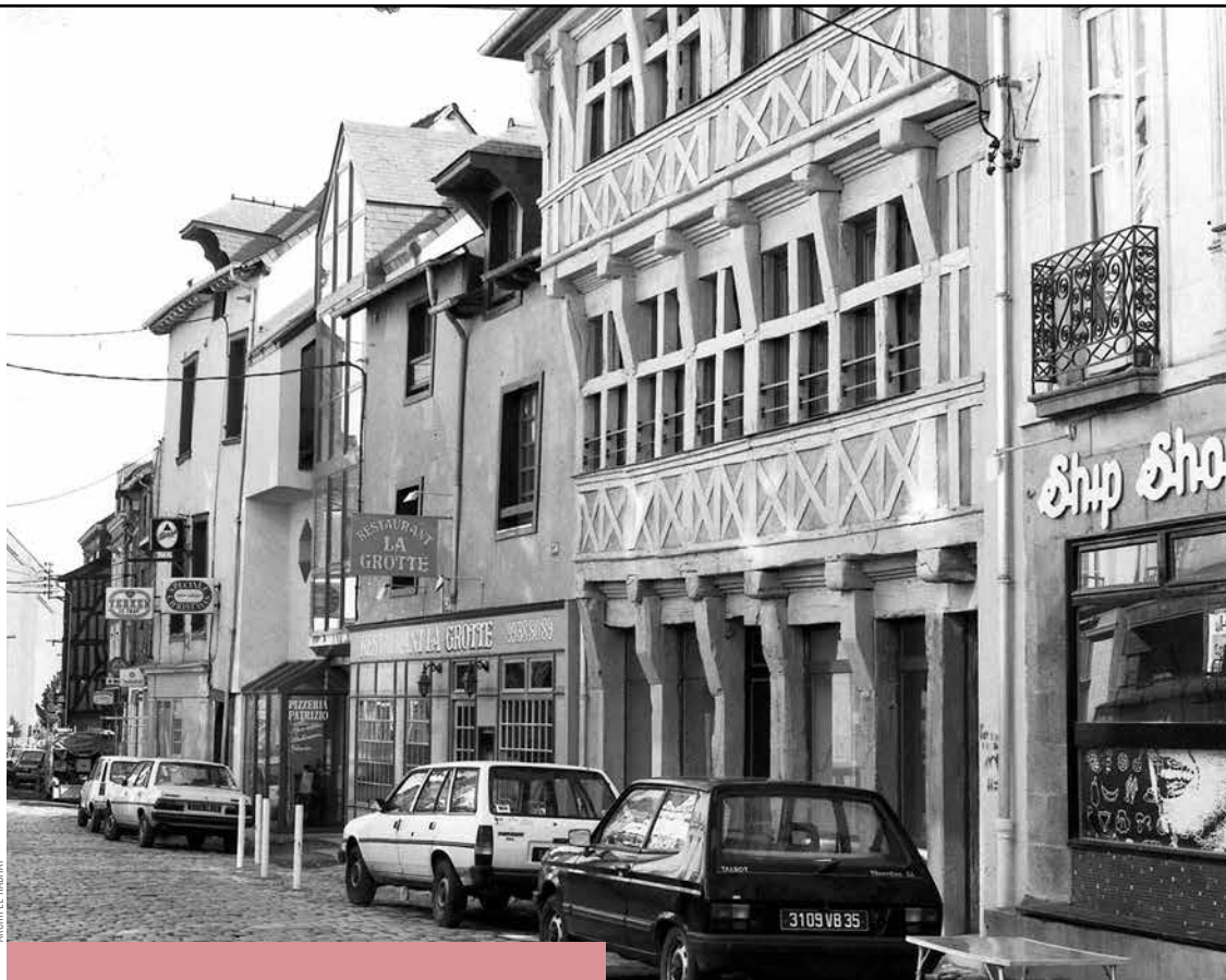
Le 32 rue Saint-Malo, après rénovation, avec sa façade à pans de bois dissimulant un bâti en béton.
