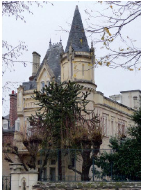
Ce système met en œuvre de vastes pièces de terre cuite moulées en série, armées de fil de fer lors du moulage afin d'augmenter leur solidité. Ce façonnage s'apparente au béton armé mais ne s'applique qu'à des éléments rapportés (baies, balustrades, corniches...) et non à la structure. Il n'est alors que peu utilisé en France. Les représentants de l'Art nouveau l'utiliseront quelques années plus tard par la mise en œuvre du grès flammé, intéressant pour sa polychromie.
