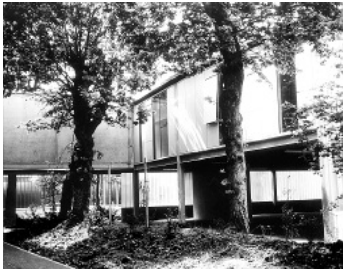
Faculté des métiers, campus de Ker Lann, Bruz, 2000. Deux vues de l'extérieur, verre Reglit, bardage acier laqué et menuiseries aluminium
