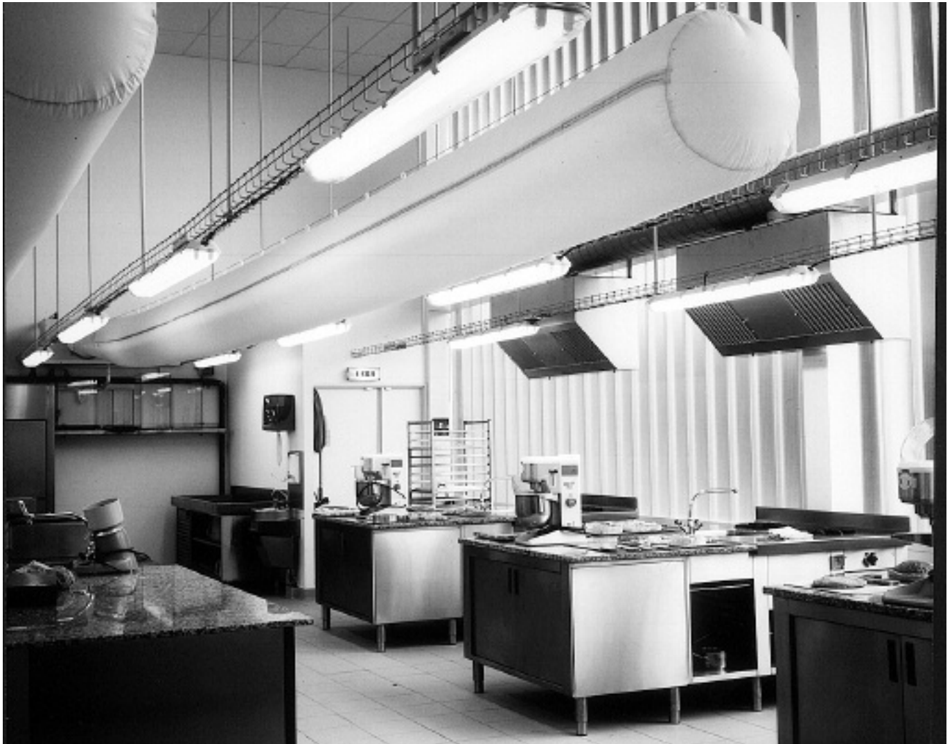
Faculté des métiers, campus de Ker Lann, Bruz, 2000. Les cuisines (pôle hôtellerie et restauration géré par la CCI).
