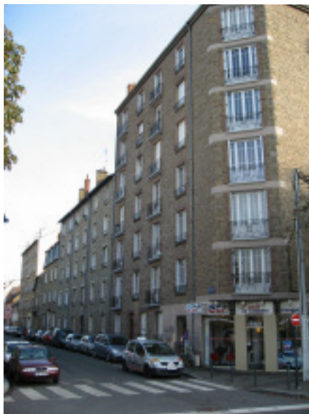
À l'angle de la rue Noël-du-Fail, immeuble plus modeste que ceux du vrai centre-ville
