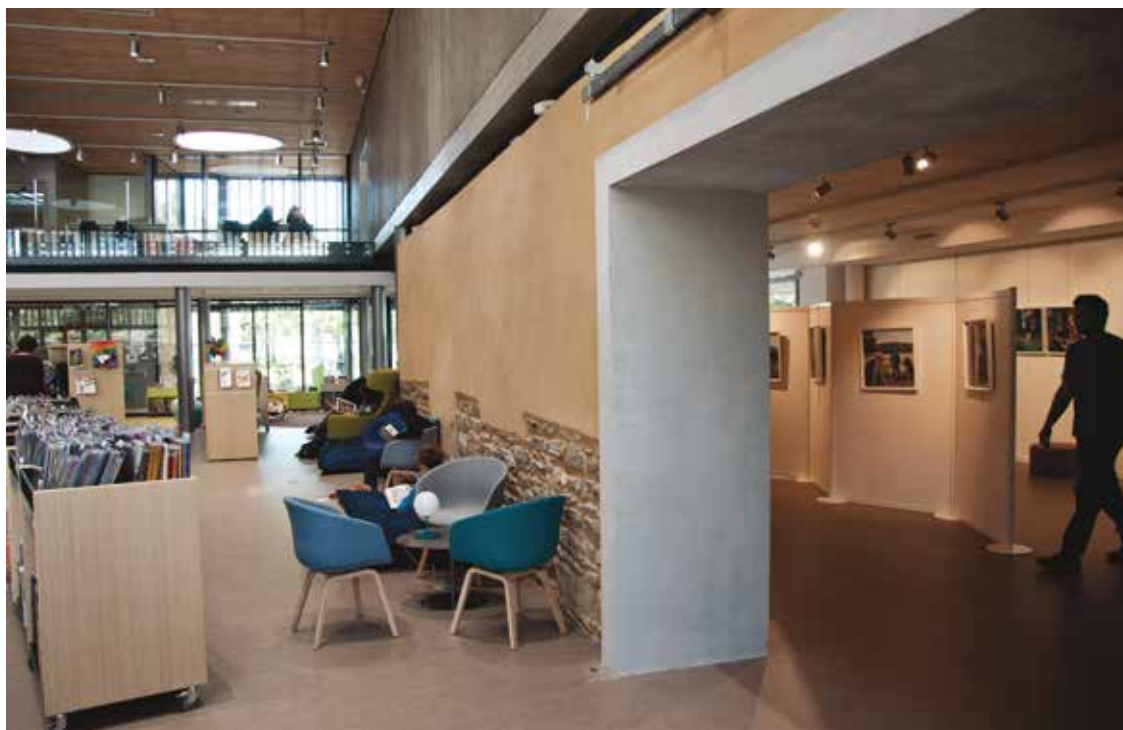
Les percements de passage à l'intérieur du bâtiment sont des U de béton. La galerie d'exposition, autonome, peut communiquer avec la médiathèque.
